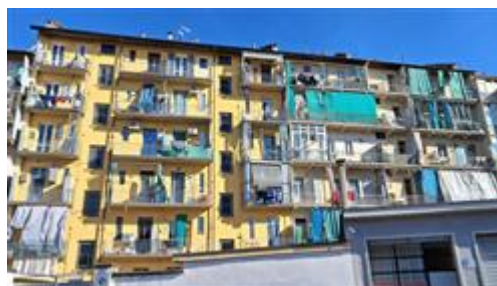
FACCIATA LATO CORTILE
