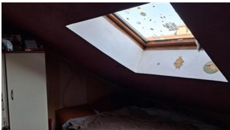
SOFFITTA - FINESTRA A RASO TETTO
